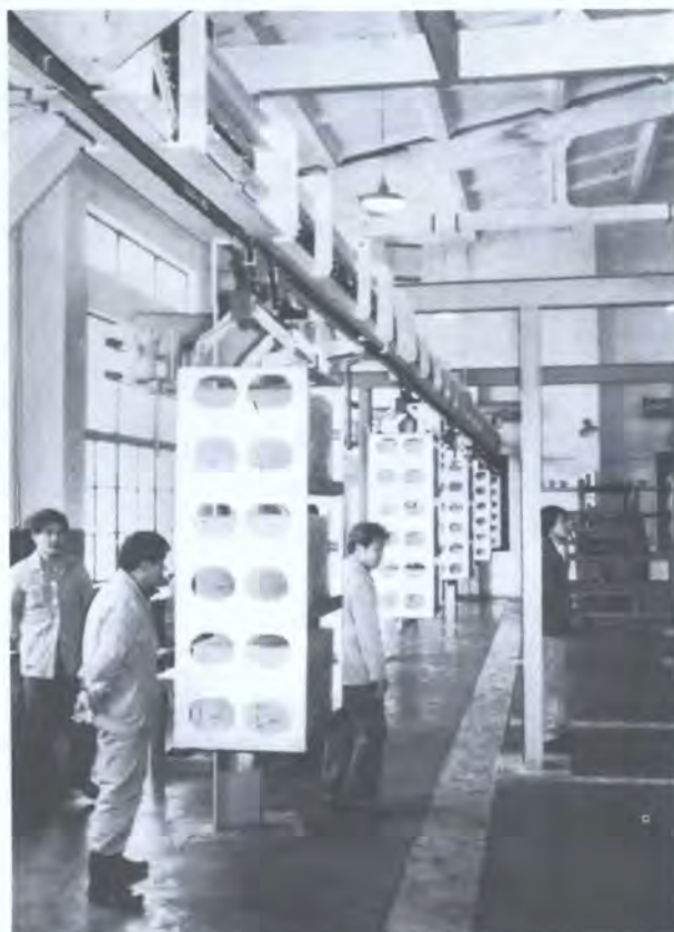
在上海辐照中心，台架上的箱装苹果被自动送到辐照室。 (来源: Wedekind)
