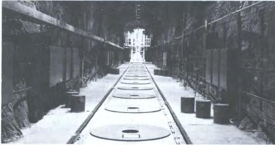
作为美国核废物管理工作的一部分，曾进行乏燃料“极点”试验，以评价在内华达试验场地下1400英尺结晶岩层中贮存反应堆乏燃料的效果。图为运输车辆把废物包装运往垂直钻入坚实花岗岩坑道地板的竖井。
