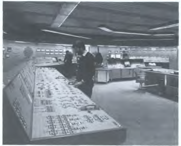
На пульте управления АЭС с хорошими эксплуатационными характеристиками: расположение и количество контролирующего персонала.
