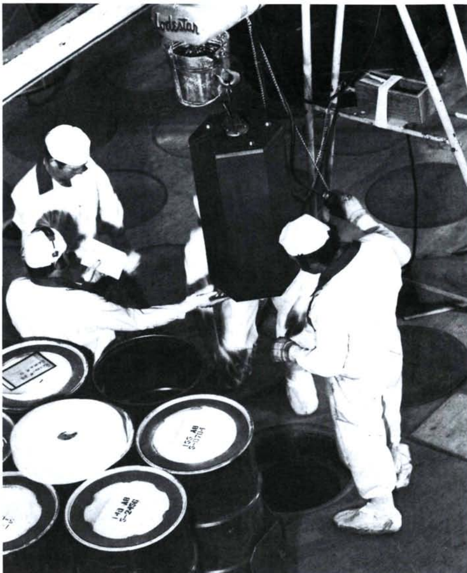
Un des 1482 blocs de combustible en graphite est inséré dans le cœur du premier réacteur HTG de taille industrielle, qui équipe la centrale de 330 MWe de Fort St. Vrain, au Colorado (Etats-Unis). Depuis sa mise en service, à la fin de 1976, cette centrale a produit plus de quatre térawatt-heures d'électricité. (Photo GA Technologies, Inc.)
