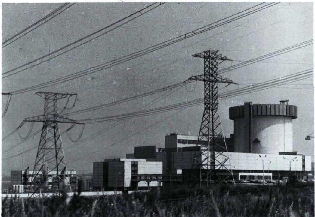
Partie de la centrale de Novo-Voronej équipée d'un WWER.
