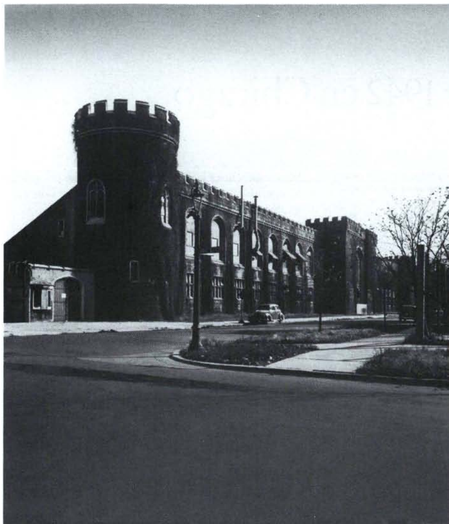
Graderío occidental de Stagg Field, Universidad de Chicago. El equipo dirigido por Enrico Fermi construyó el primer reactor nuclear del mundo dentro de este edificio. A las 15,25 del 2 de diciembre de 1942 se retiró del reactor una barra de cadmio de control y se inició la primera reacción nuclear artificial en cadena automantenida. (Fotografía: Argonne National Laboratory)
