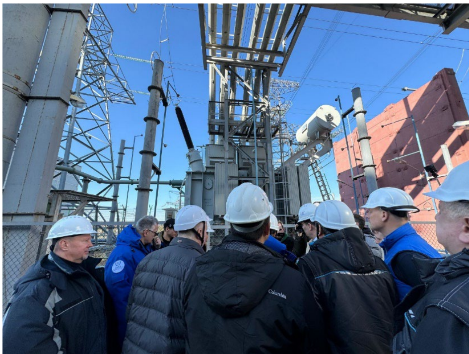
2024年2月7日，总干事拉斐尔·马利亚诺·格罗西查看扎波里日亚核电站备用电力变压器。
