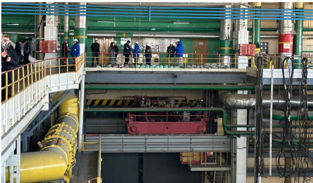
2024 年 2 月 7 日，拉斐尔·马利亚诺·格罗西总干事 查看扎波里日亚核电厂 4 号机组涡轮大厅。
