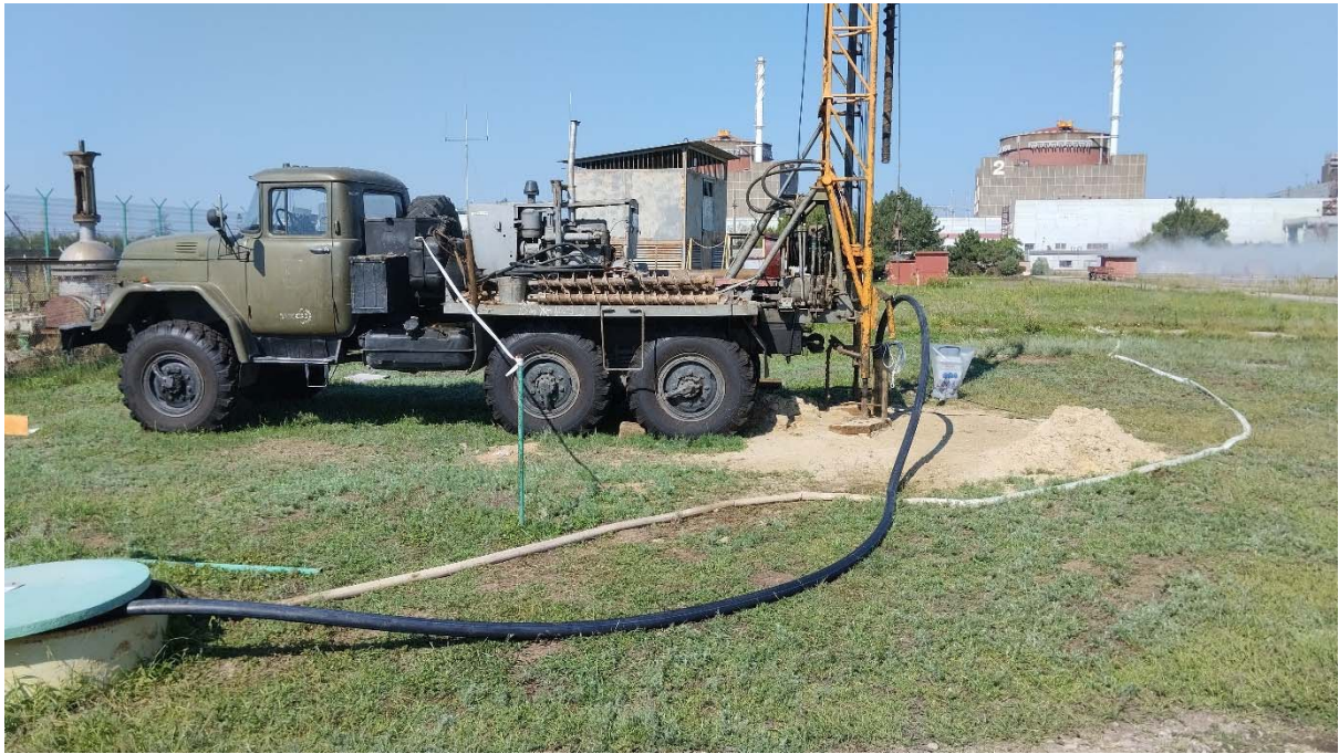
Бурение дополнительных скважин на площадке ЗАЭС. (Фото: Росатом)
