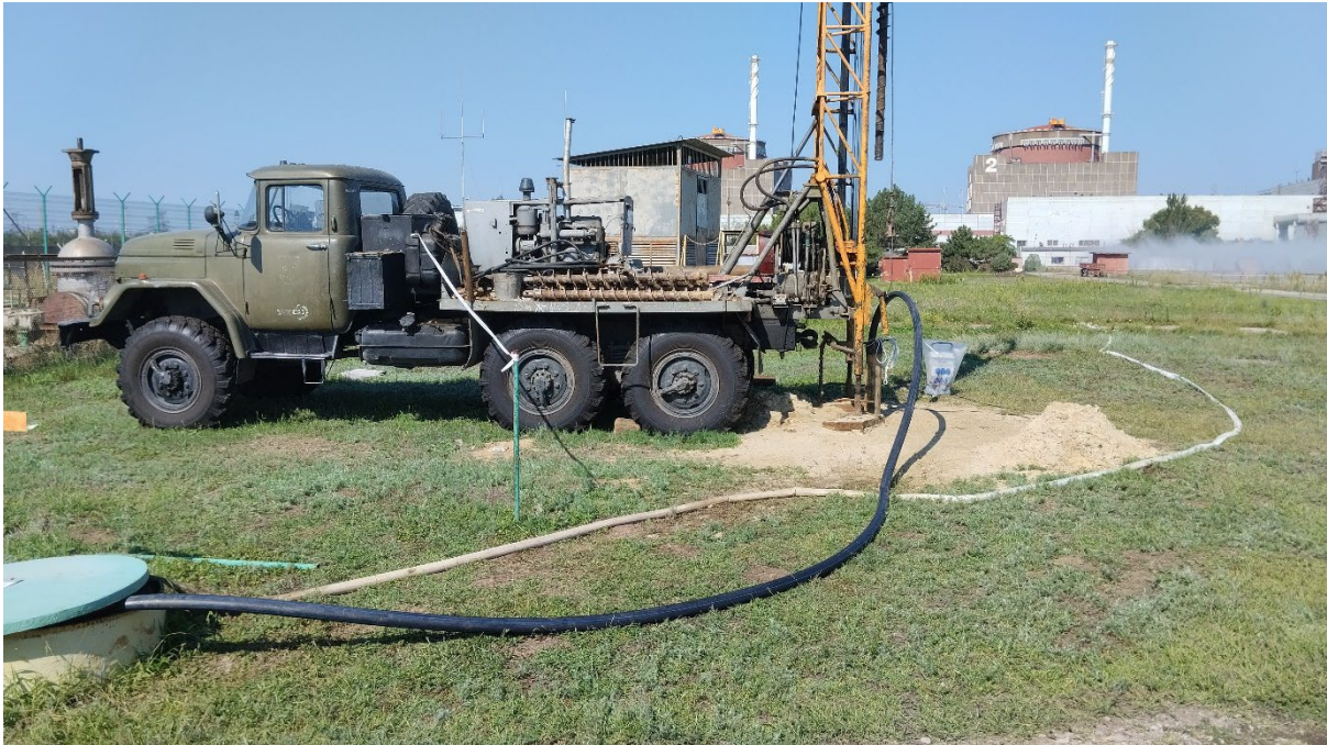
在扎波里日亚核电厂场址钻探更多水井。(照片来源：国家原子能公司)
