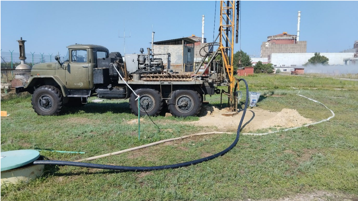
حفر آبار إضافية في موقع محطة زابوريجيا للقوى النووية. (الصورة من: روزاتوم)
