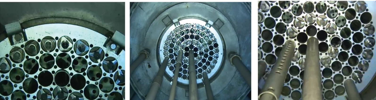
Визуальный осмотр и неразрушающий контроль используются для оценки безопасности и эксплуатационных условий конструкций, систем и элементов реакторной установки, включая опору и решетку активной зоны реактора.
