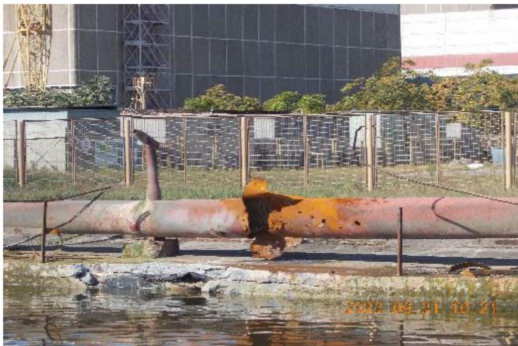
*L'ISAMZ observe un tuyau endommagé par un bombardement survenu le 21 septembre au site de la centrale nucléaire de Zaporizhzhia (Photo : AIEA)*
