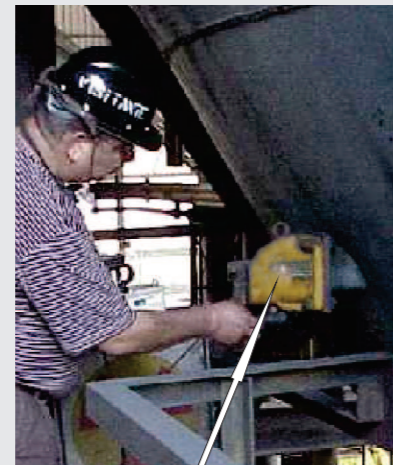
料位计的源箱包含一个伽玛源。探测器位于容器的对面。
