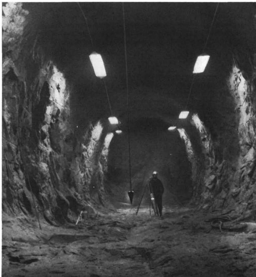
La antigua mina de hierro de Stripa, en Suecia, ha sido elegida como lugar de ejecución de un proyecto conjunto sueco-americano para ensayar la idoneidad del granito para el almacenamiento de desechos nucleares. Las galerías de la mina forman un laberinto y la fotografía muestra una de las galerías que se están investigando. Foto: AB Atomenergi, Suecia.
