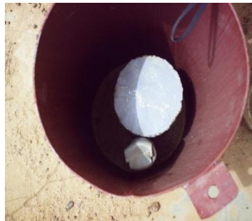
Piézomètres: 2 tubes captant des niveaux différents des niveaux .
