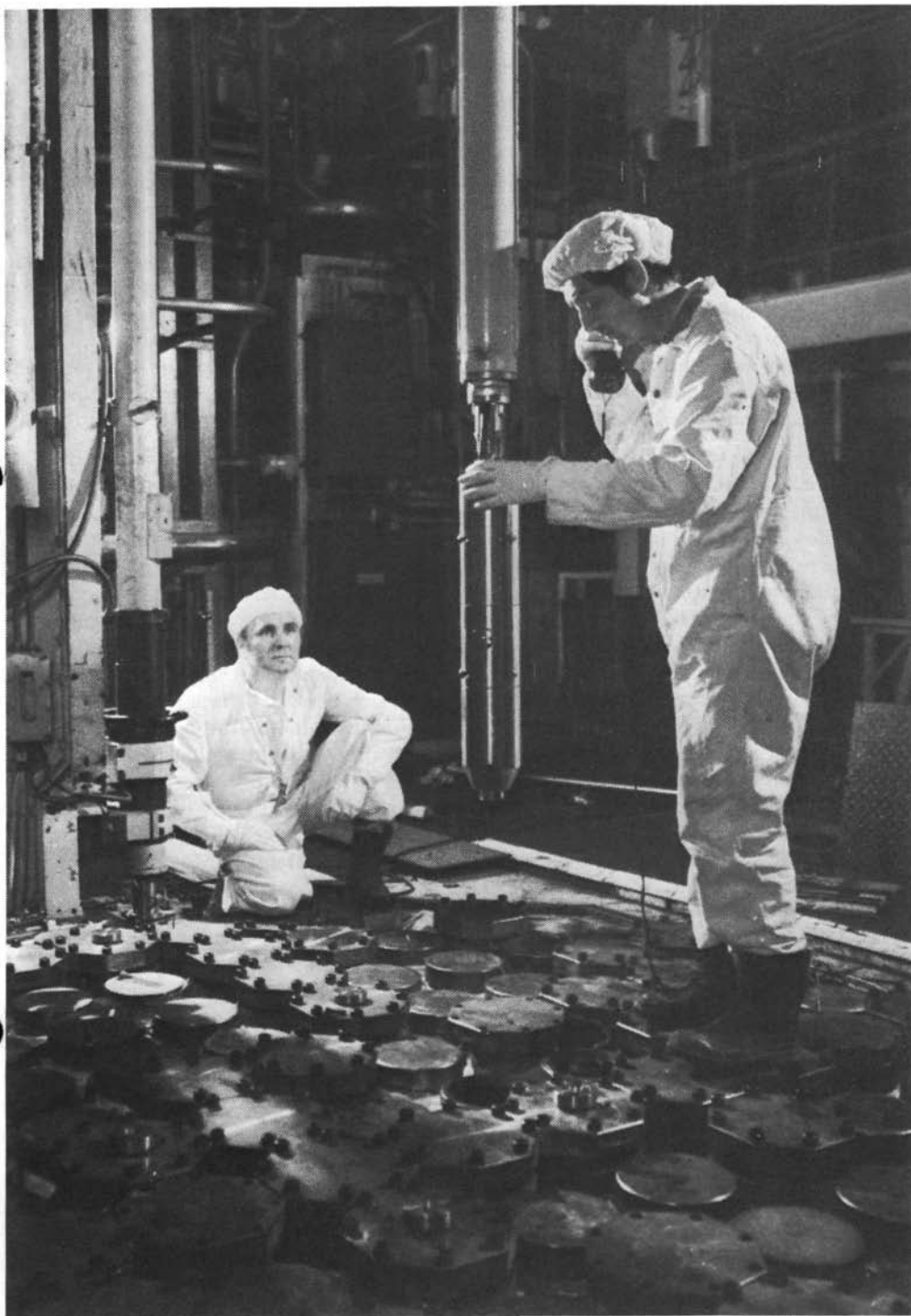
Aspecto del reactor de agua pesada generador de vapor de Winfrith, en Inglaterra: verificación del diámetro de los distintos tubos de presión durante una parada del reactor para proceder a la recarga de combustible. Foto: UKAEA.
