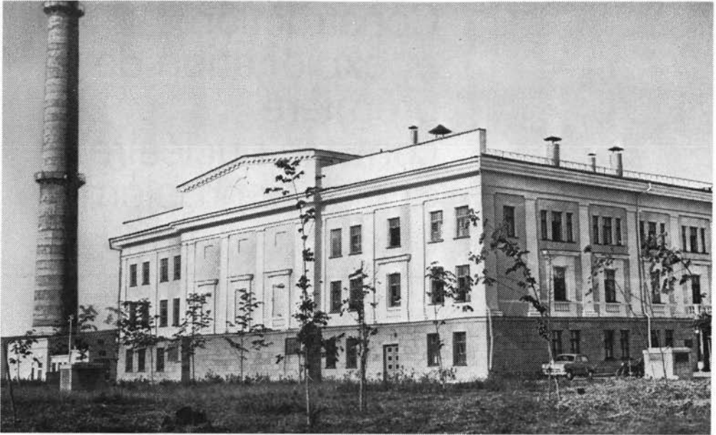
La première centrale nucléaire construite en 1954 à Obninsk (Union soviétique), Photo: Tass.
