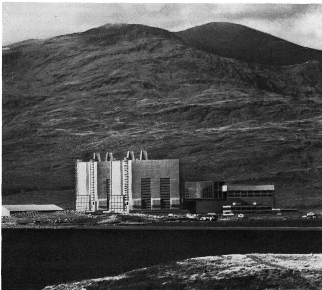
La Centrale Magnox de 500 MW du Central Electricity Board construite sur la rive nord du lac Trawsfynydd dans la première qui utilise un lac comme source d'eau de refroidissement.
