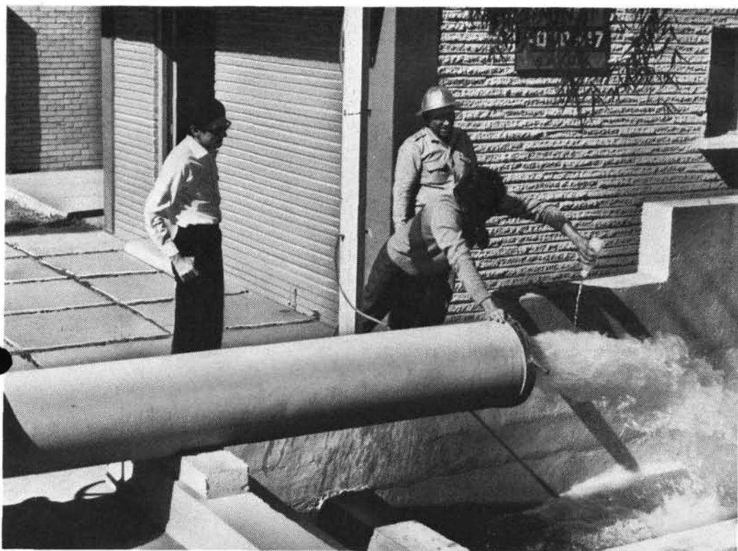
Muestreo de agua subterránea de uno de los pozos abiertos en La Mina, cerca de Monterrey (México), para analizar su contenido de isótopos estables y tritio. Foto: OIEA/Payne
