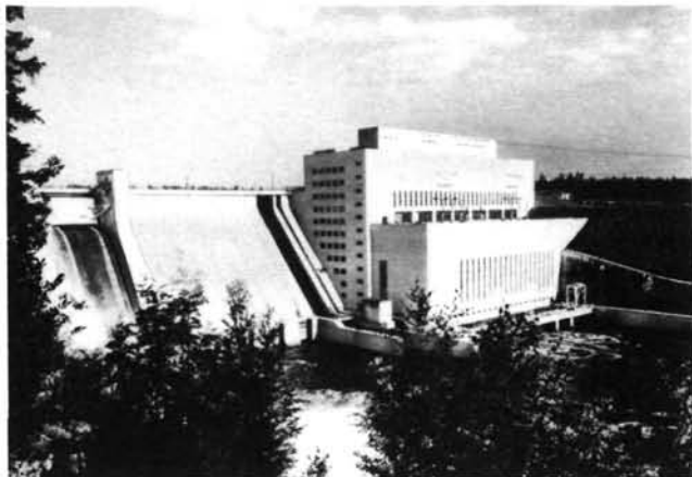
Centrale hydroélectrique de Pyhäkoski, construite sur l'Oulu, dans le centre de la Finlande. En Finlande, l'électricité est en grande partie d'origine hydraulique, mais on prévoit que le rôle des centrales thermiques deviendra plus important dans l'avenir.
