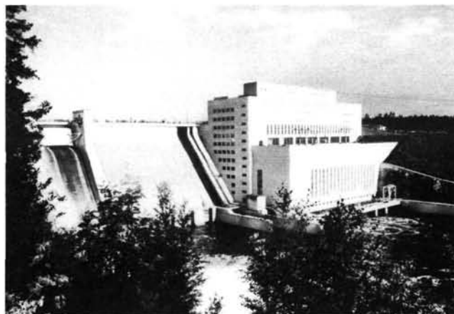
Central hidroeléctrica de Pyhäkoski, sobre el río Oulu, en la región central de Finlandia. En la actualidad, la mayor parte de la electricidad producida en Finlandia es de origen hidráulico, pero se estima que en el futuro las centrales térmicas desempeñarán un papel más importante
