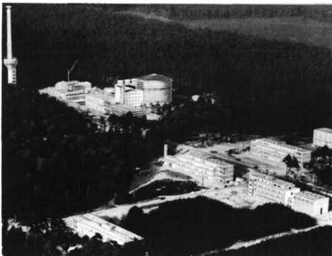
Centro de investigación en las proximidades de Karlsruhe. Al fondo, a la izquierda, el reactor FR 2
