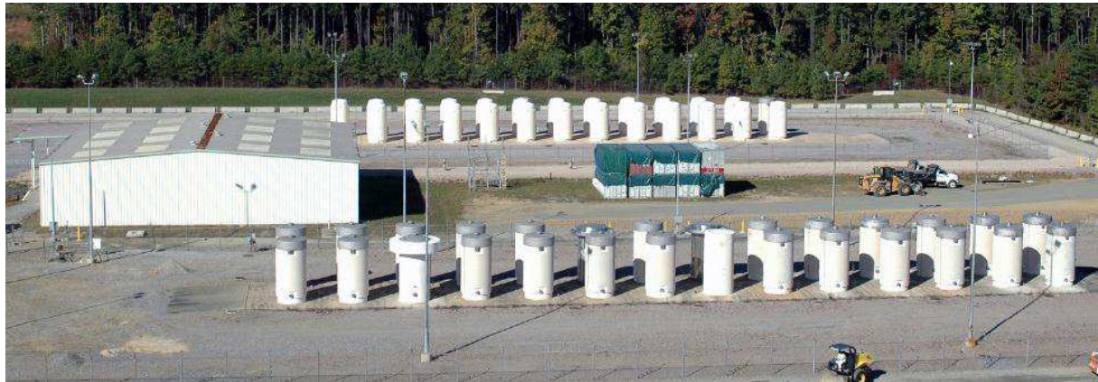
الشكل-٤- المنشأة المستقلة لخرن الوقود المستهلك في محطة سري للقوى النووية في ولاية فرجينيا، الولايات المتحدة الأمريكية، وهو مرفق للخرن الجاف في براميل في موقع المفاعل.
