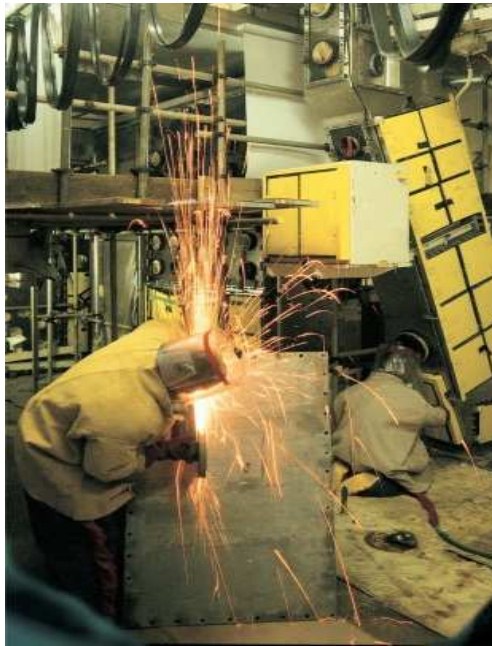
الشكل-١ - إخراج وحدة قياس مغلقة من الخدمة في مرفق لصنع الوقود.
