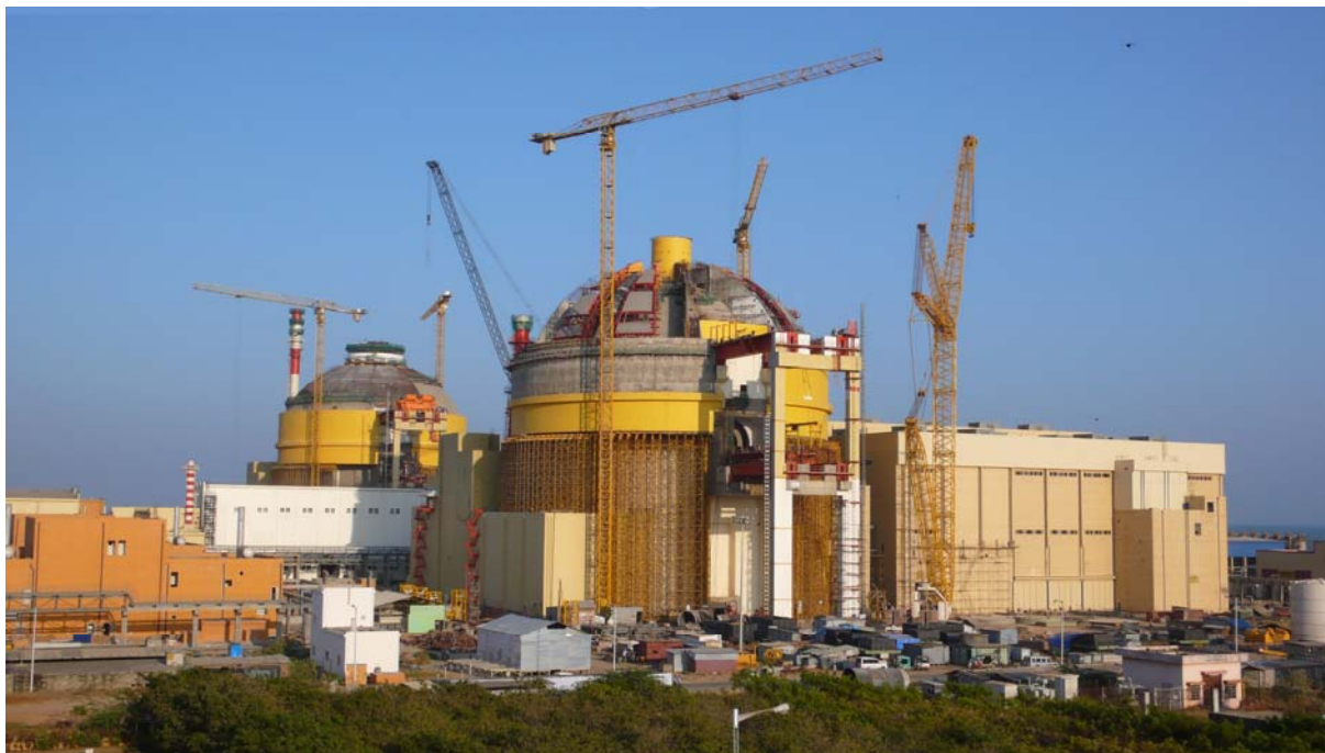
РИС. 1. Строительство водоохлаждаемых реакторов (2 × 917 МВт (эл.)) в Кунданкуламе, Индия.
