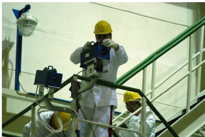
РИС. 2. Монтаж оборудования для наблюдения на ядерной установке.
