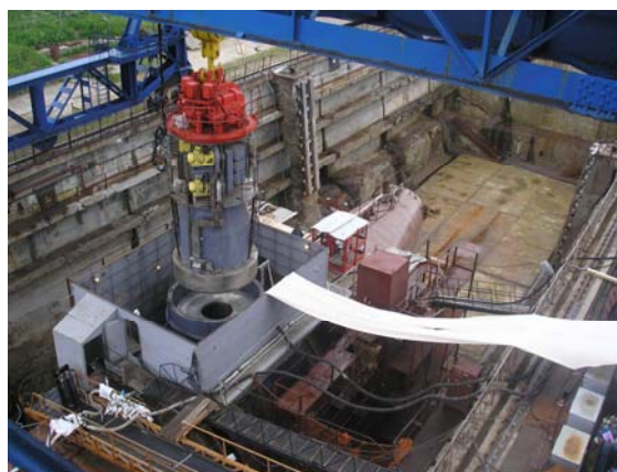
Рис. 6. Выгрузка топлива с поврежденной атомной подводной лодки предполагала извлечение активной зоны реактора с жидкометаллическим теплоносителем.
