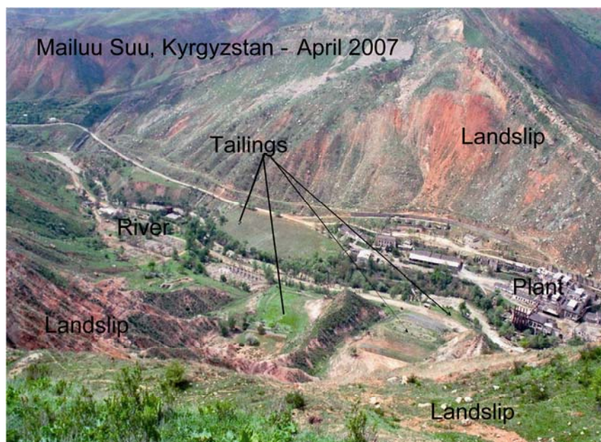
РИС. 5. Объект Майли-Сай в Кыргызстане. Хвостохранилища видны на центральной части снимка, а потенциальные оползни – слева (земля красного цвета) и по ту сторону реки на склоне горы.
