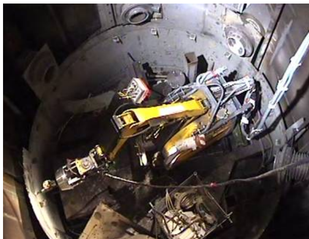
РИС. 3. Дистанционно управляемая операция по удалению облицовки на исследовательском реакторе СИЛОЕ в Гренобле, Франция.
