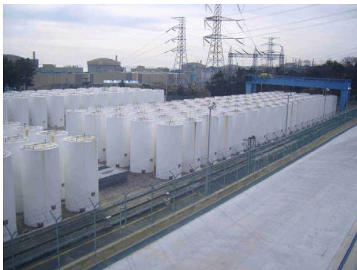
Рис. 2. Контейнеры для сухого хранения на площадке АЭС "Ульсан" в Республике Корея.
