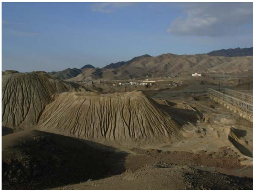
*РИС. 4. Отвал хвостов обогащения и установка для кислотного выщелачивания на заброшенной площадке в Табошаре, Таджикистан (обратите внимание на деревню и школу вдали).*
