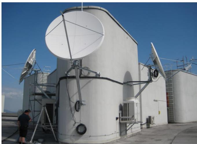
*РИС. 7. Станция спутниковой связи для приема данных дистанционного мониторинга в Центральных учреждениях Агентства.*
