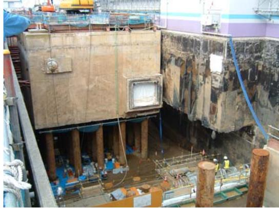
*РИС. 2. Удаление, очистка и замена загрязненной нефтью почвы под свайным фундаментом конструкции, не связанной с безопасностью, на АЭС "Касивадзаки-Карива".*
