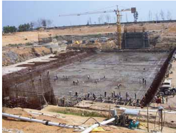
Fig. 2. Construcción del reactor reproductor rápido de Kalpakkam, Tamil Nadu, en la India.
