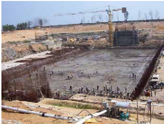
图 2. 印度卡尔帕卡姆快中子增殖堆建设工地。
