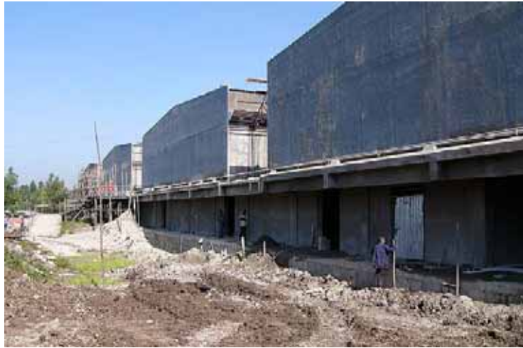
图 2. 埃塞俄比亚正在建造的一个大型采采蝇饲养设施。
