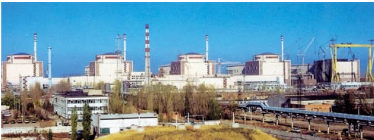
Балаковская АЭС NPP at Balakovo
