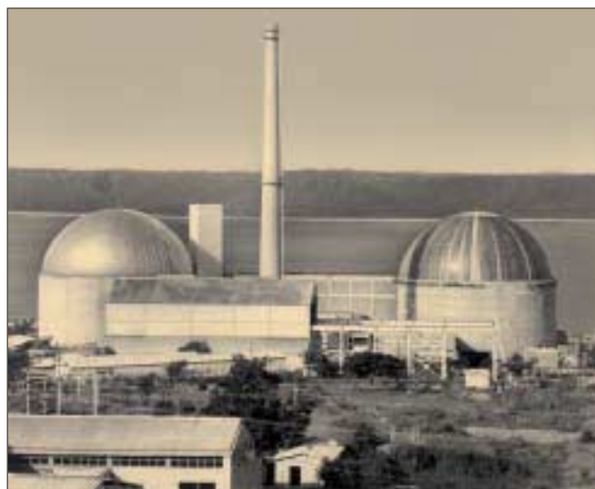
Атомная электростанция в индийском штате Раджастан, первая очередь которой была пущена в 1972 г.
