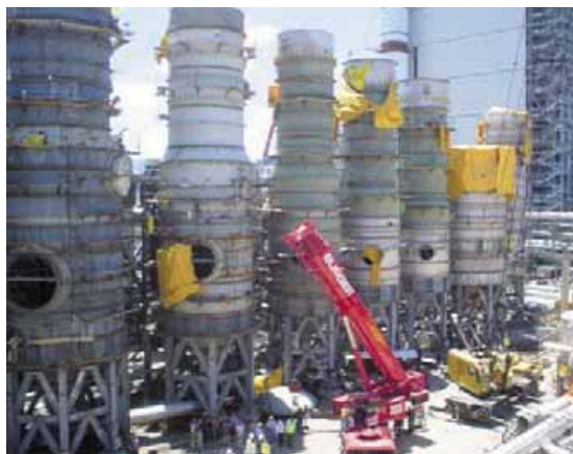
Planta de celulosa en construcción. Fotografía: Comisión Chilena de Energía Nuclear
