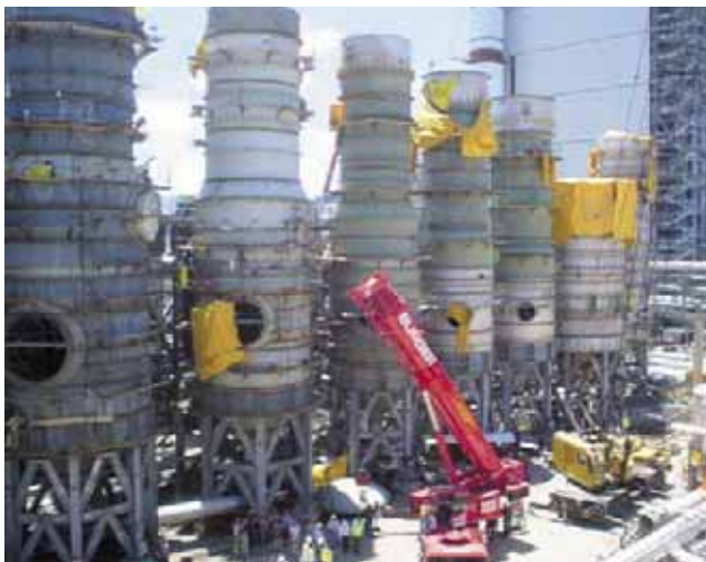
Chantier de l'usine de fabrication de cellulose. Photo: Commission chilienne de l'énergie nucléaire
