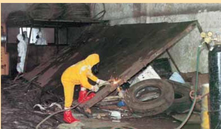
Trabajos de descontaminación en un parque de chatarra
