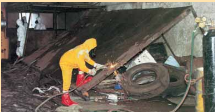
Работа по дезактивации на ломоразделочной площадке
