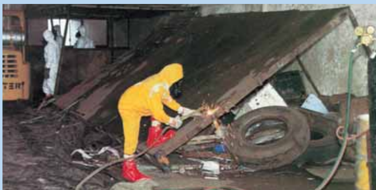
Photo de couverture : Découpage d'une pièce de métal contaminée pour la retirer de l'entrepôt d'un dépôt de ferraille. Source : CNEN (Brésil)
