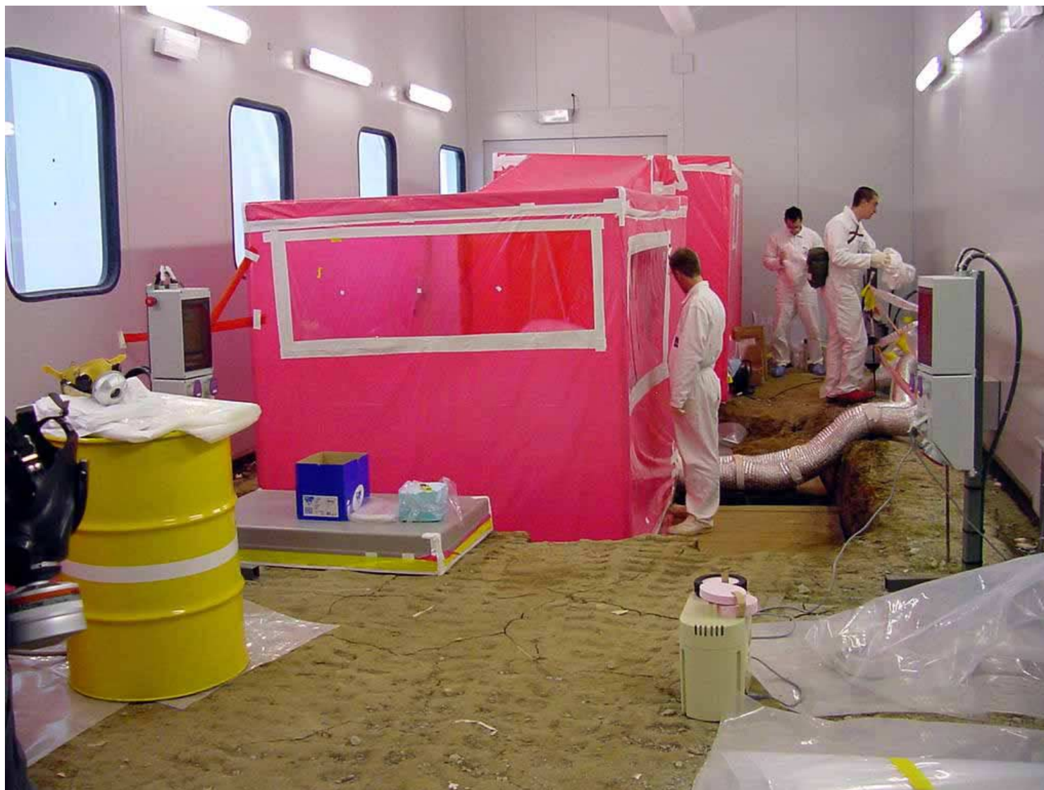
Работы по реабилитации при помощи ПГУО
