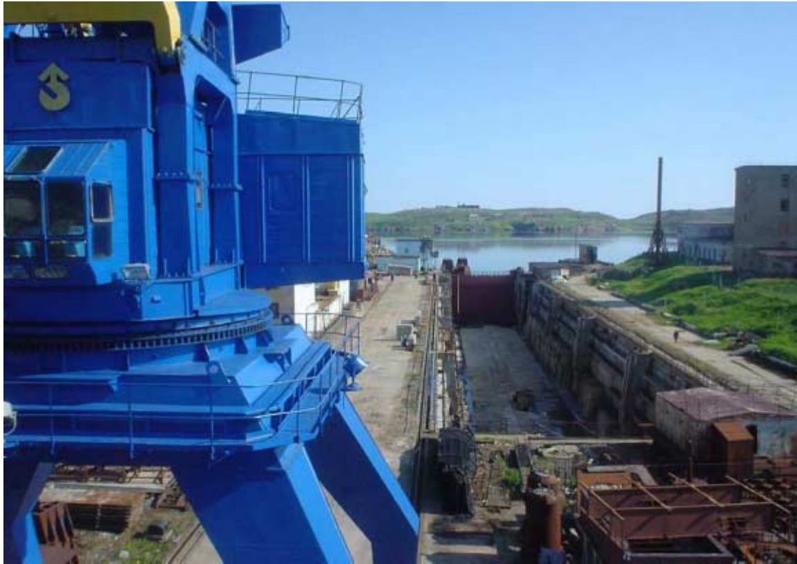
Фото № 1. Вид сухого дока и портального крана
