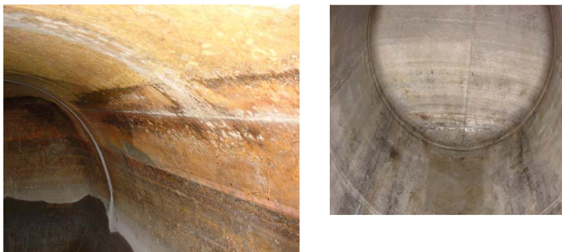
Рис. 2. Внутренние поверхности баков до и после дезактивации
