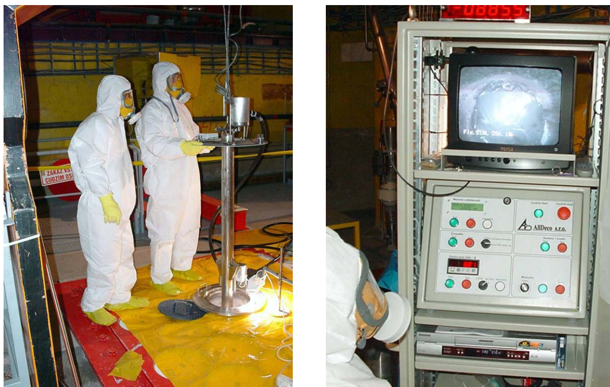
Рис. 4. Иммобилизация шлама на дне пенала с использованием установки FIZA
