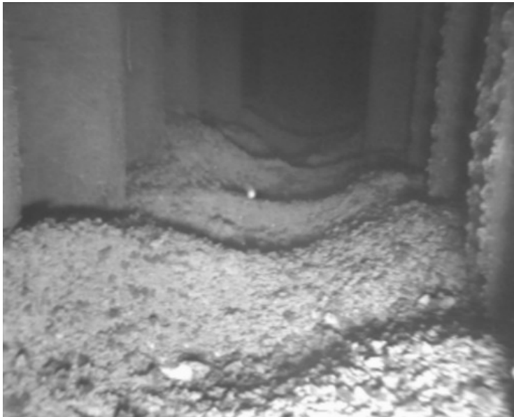
Рис. 2. Шлам на дне бассейна долговременного хранилища и пенала отработанного топлива
