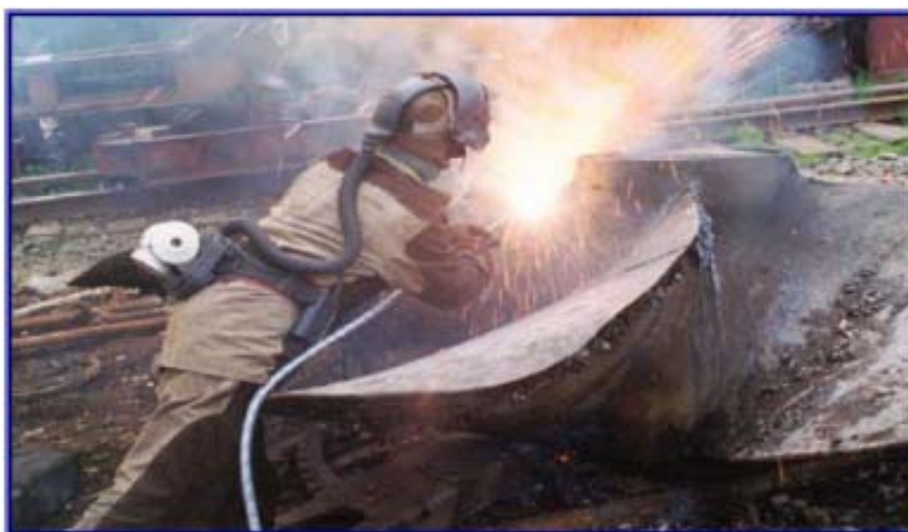
Рис. 4. Газовая резка при утилизации АПЛ
