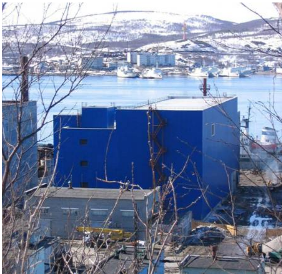
Рис. 3. Здание контейнерного хранилища
